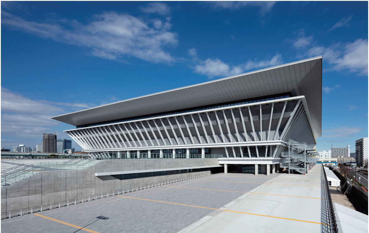
南東外観（東京 2020 大会時）：辰巳の森海浜公園側に大階段広場＋観客用のメインエントランスを配置
