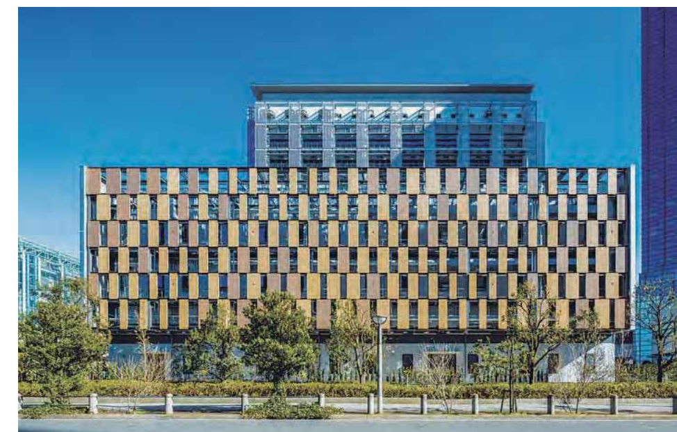
産業技術総合研究所臨海副都心センター 第二別館 サイバーフィジカルシステム研究棟
