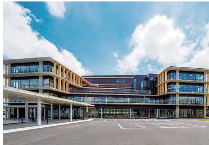
大津町庁舎 ZEB Ready
