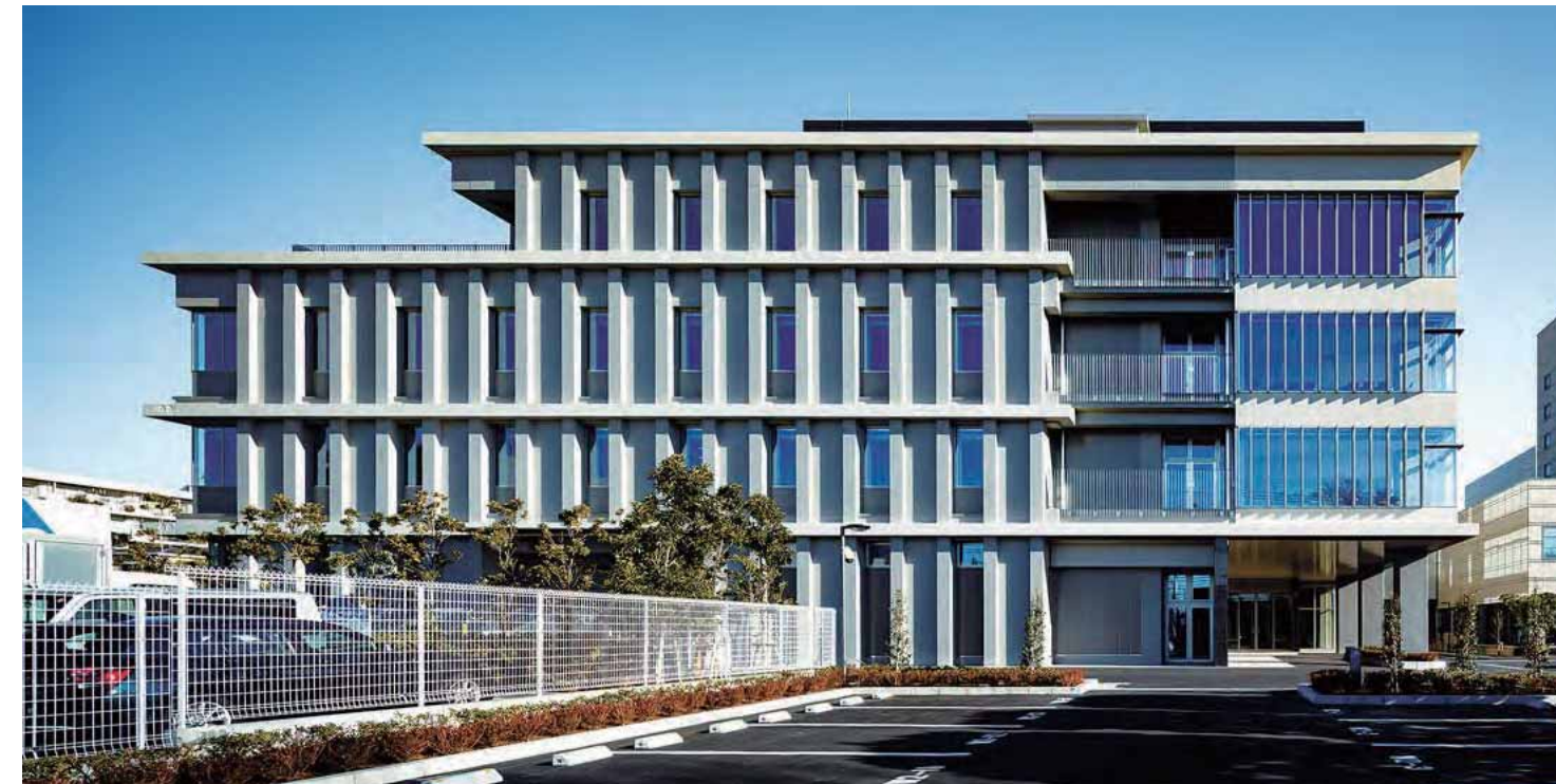
TDKテクニカル センター-W2棟
