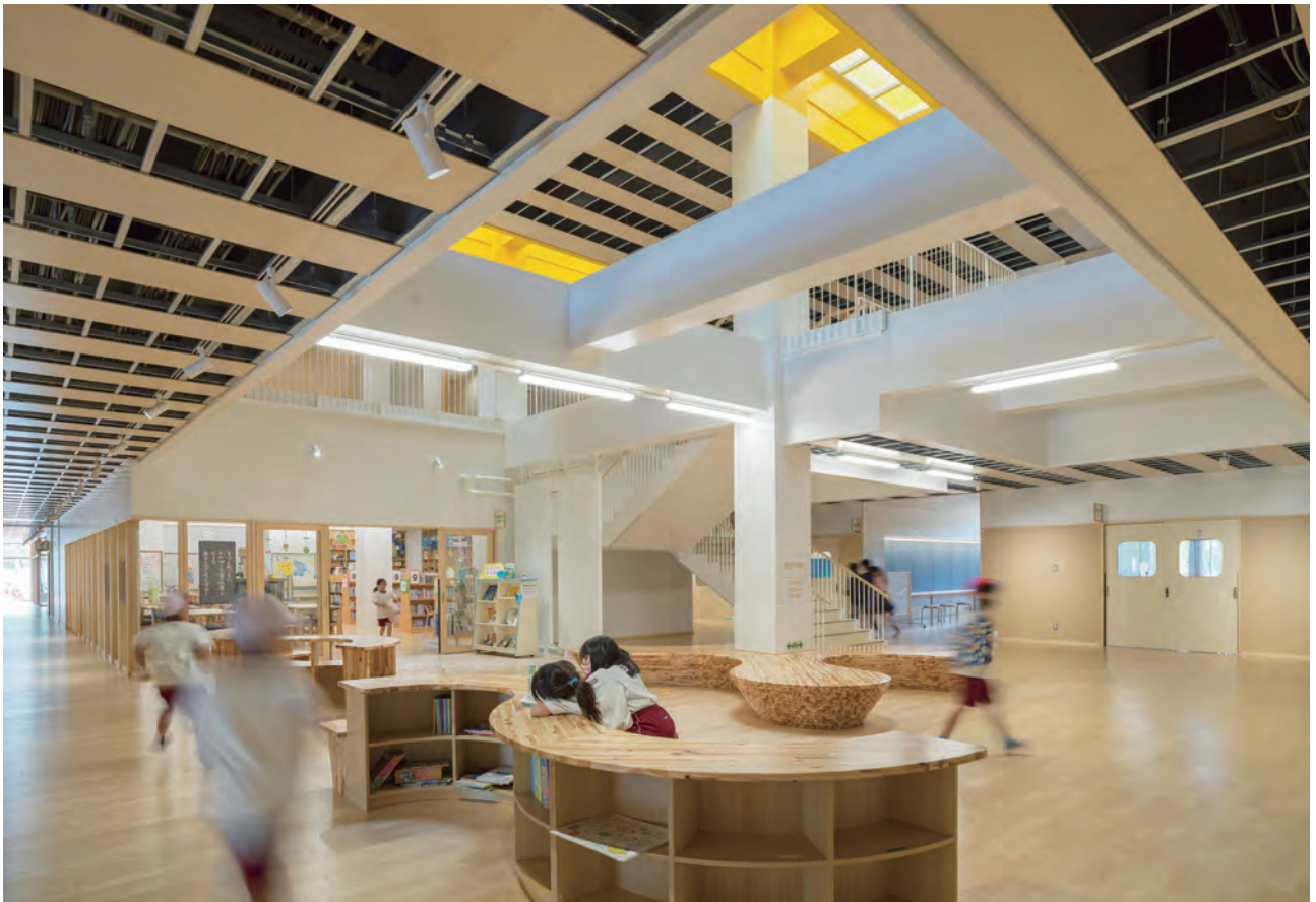
校舎中央に配置した読書ラウンジ 既存スラブを撤去して吹抜空間とした
