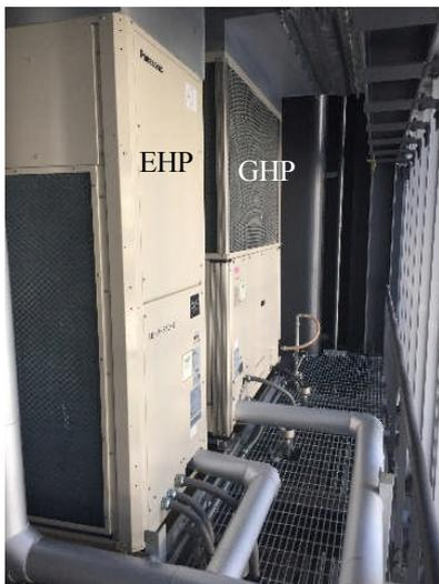
写真3 スマートマルチ (設備バルコニー設置)
