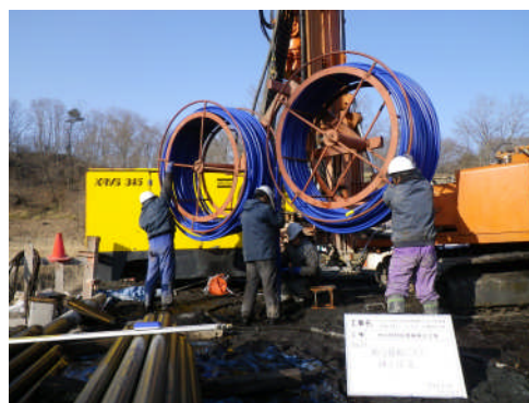
写真-2. 地中熱交換器敷設工事
