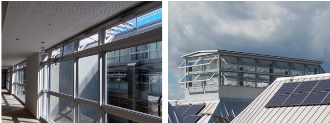
写真-1 2 階北側中庭開口部 写真-2 屋上(南側)排気塔開口部
