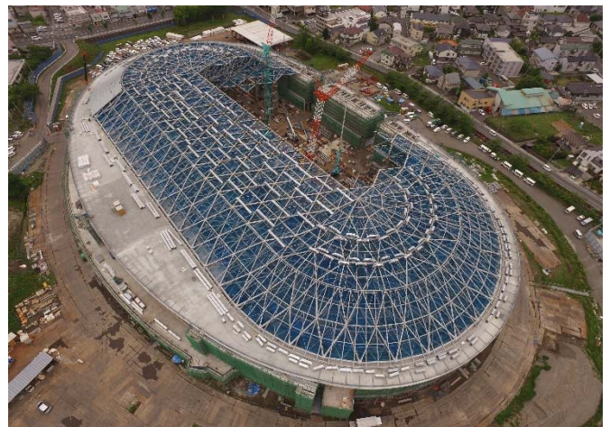
写真3 斜めグリッド格子トラス（建て方時）
