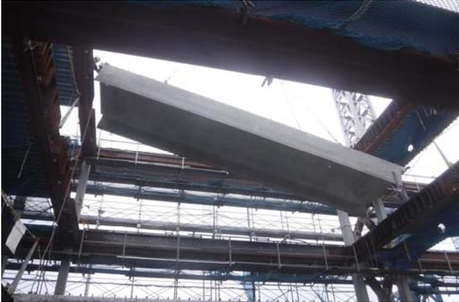
写真-10 PC床版の架設状況
