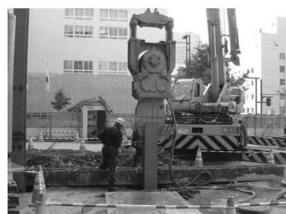
リユース先での施工(10/17)
