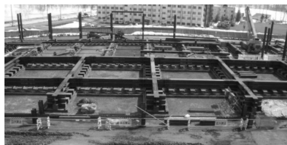
写真2 直接基礎(置き基礎)の設置状況
