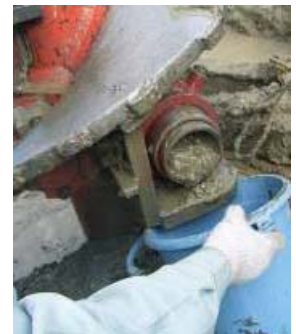
図3 深度と比抵抗値 写真3 根固め液取出状況
