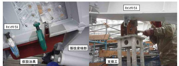
写真 4. 仮設治具を用いた接合
