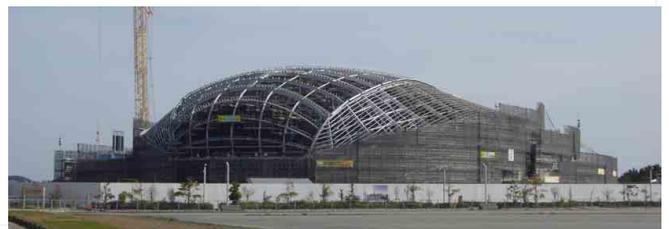
写真 6. 屋根架構建方完了状況 (2010.3.30 撮影)
