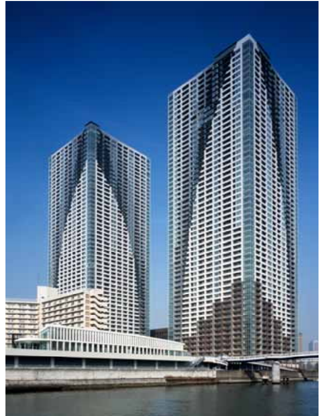
写真-1: THE TOKYO TOWERS 全景
