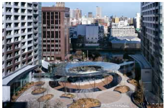
写真-2: 3階人工地盤テラスプラザ(アクアステージ)
