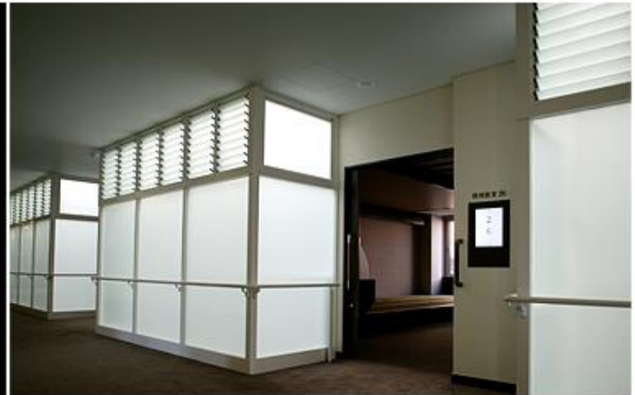
札幌市山口斎場 2階光ダクト
