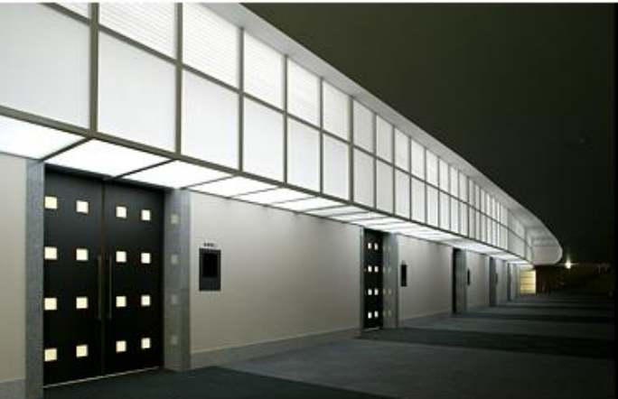
札幌市山口斎場 1階光ダクト
