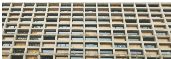
図3 彫りの深い RC フレームに CLT パネルを配置
